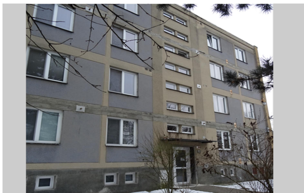
Pohled celkový na bytový dům Nejedlého ev.č.374
