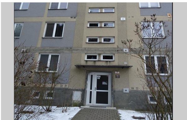
Pohled na vstup do budovy
