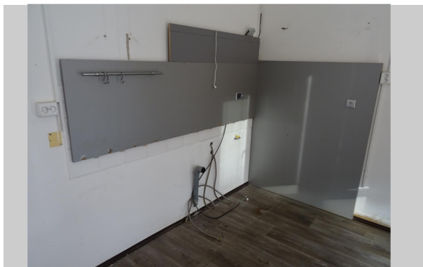
Pohled na část kuchyně bez kuchyňské linky
