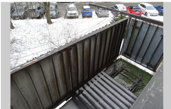
Pohled na balkon z chodby bytové jednotky
